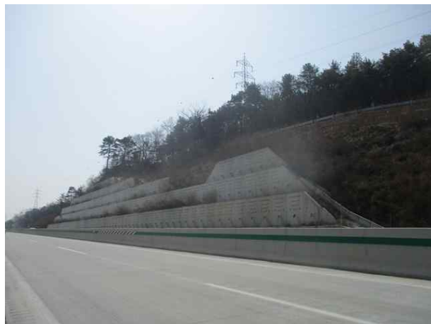
4공구 판넬식옹벽 (STA.24+249~24+392)
