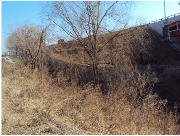
1공구 보강토옹벽(본선 STA.0+283~0+400)
