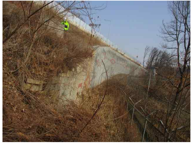
1공구 보강토옹벽(본선 STA.1+914~2+020)
