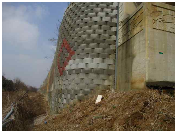
1공구 보강토옹벽 (지선 STA.0+321~0.680)
